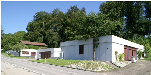
GWVZO Anlage Mühleholzli
