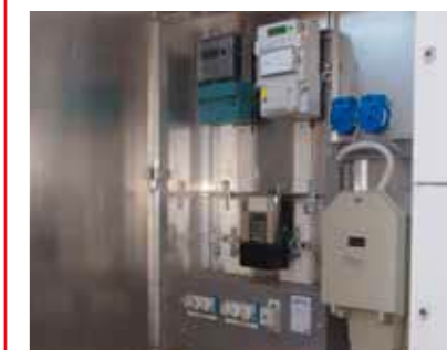
Hausanschlusskasten (HAK)
