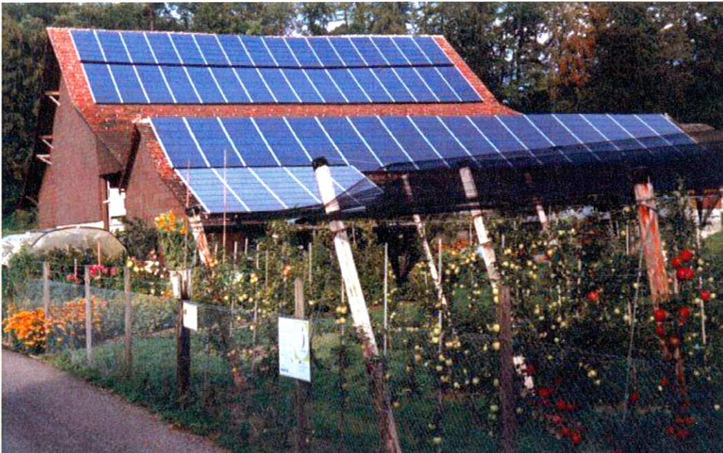
Solarstromanlage 22,8 kW peak
