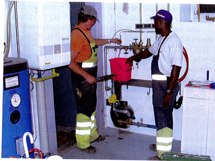
Erneuerung Hausanschlüsse; Heinz Cafilich u. Callistus Ezeafulukwe
