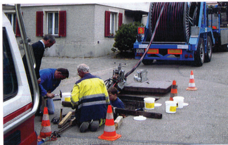
Kabeleinzug Netzbau
