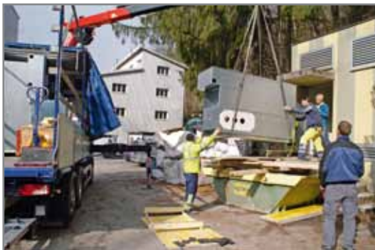
Lieferung der neuen HS-Anlage
