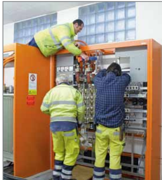
Abbruch Niederspannungs-Anlage
