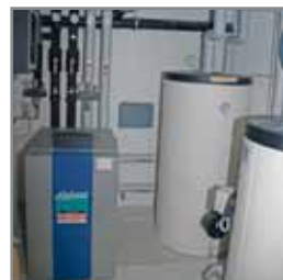
Wärmepumpe mit Boiler und Puffer Während der Bohrung auf eine Tiefe von 200 m in unwegsamem Gelände. Dauer 2 Tage.
