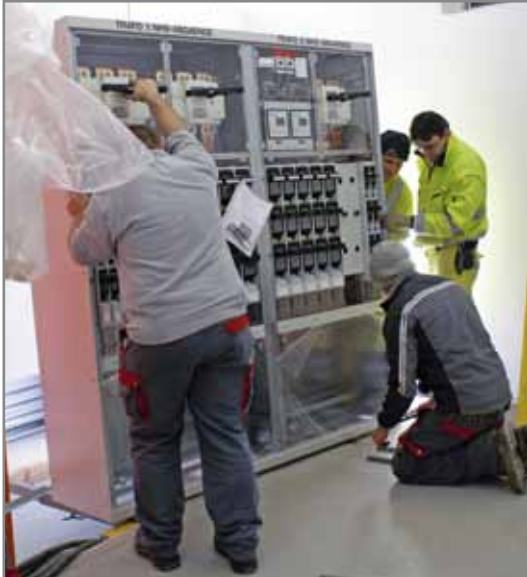
Lieferung und Montage der neuen NS-Anlage
