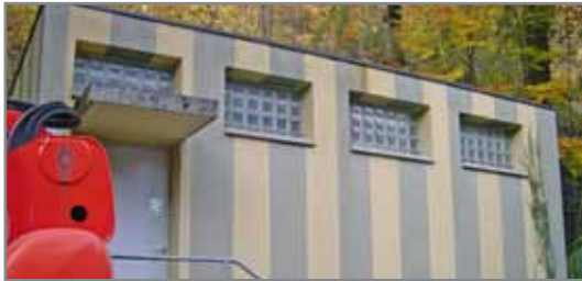
Trafostation Aussenansicht alt
