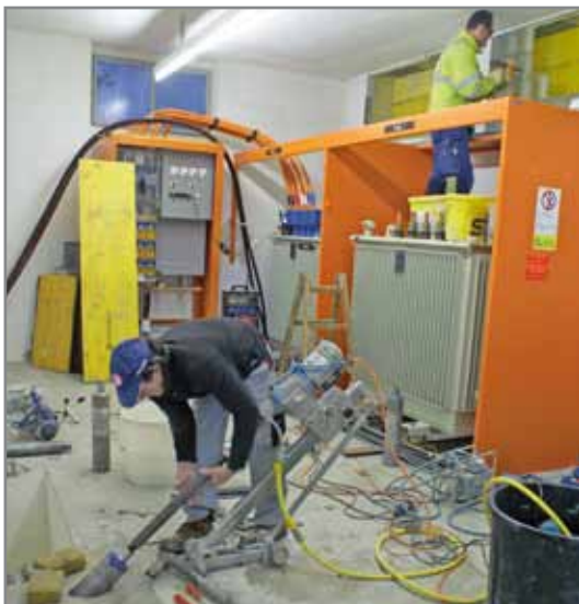
Abbruch Glasziegel, diese wurden durch Druckentlastungsgitter ersetzt. Neue Kernlochbohrungen für Kabeleinführungen der neuen HS-Anlage
