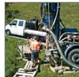
Wärmepumpe mit Boiler und Puffer Während der Bohrung auf eine Tiefe von 200 m in unwegsamem Gelände. Dauer 2 Tage.
