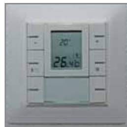
Raumthermostat mit Soll- und Ist-Temperatur-Anzeige sowie weiteren frei programmierbaren Tasten
