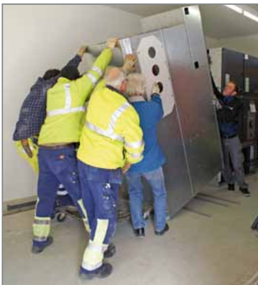
Montage neue HS-Anlage
