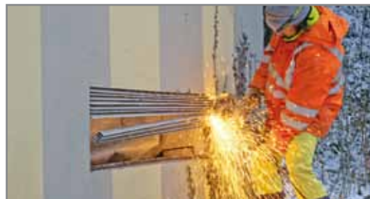
Entfernung alter Trafo-Lüftungsgitter
