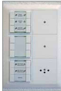
Digitale Schalter, beschriftet mit Raum oder Leuchte und Funktion des Schalters – eine saubere Sache
