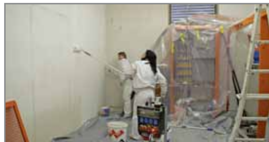
Malerarbeiten; gesamtes Gebäude innen und aussen
