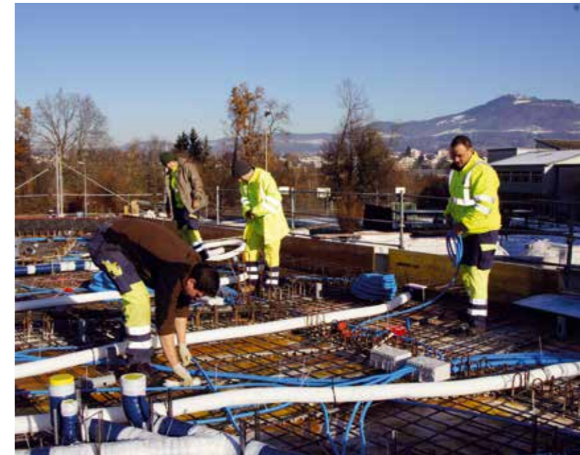
Regio 144 – Rohre verlegen
