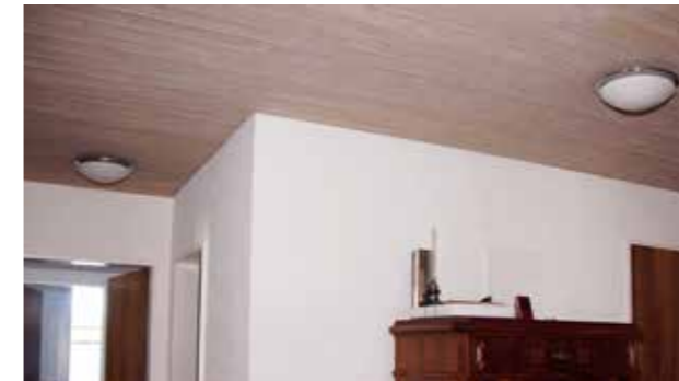
Blaser – alte Eingangsbeleuchtung
