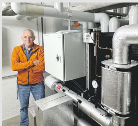
René Boller beim neuen Fernwärmeanschluss des VZO-Busdepots in Rütli.
