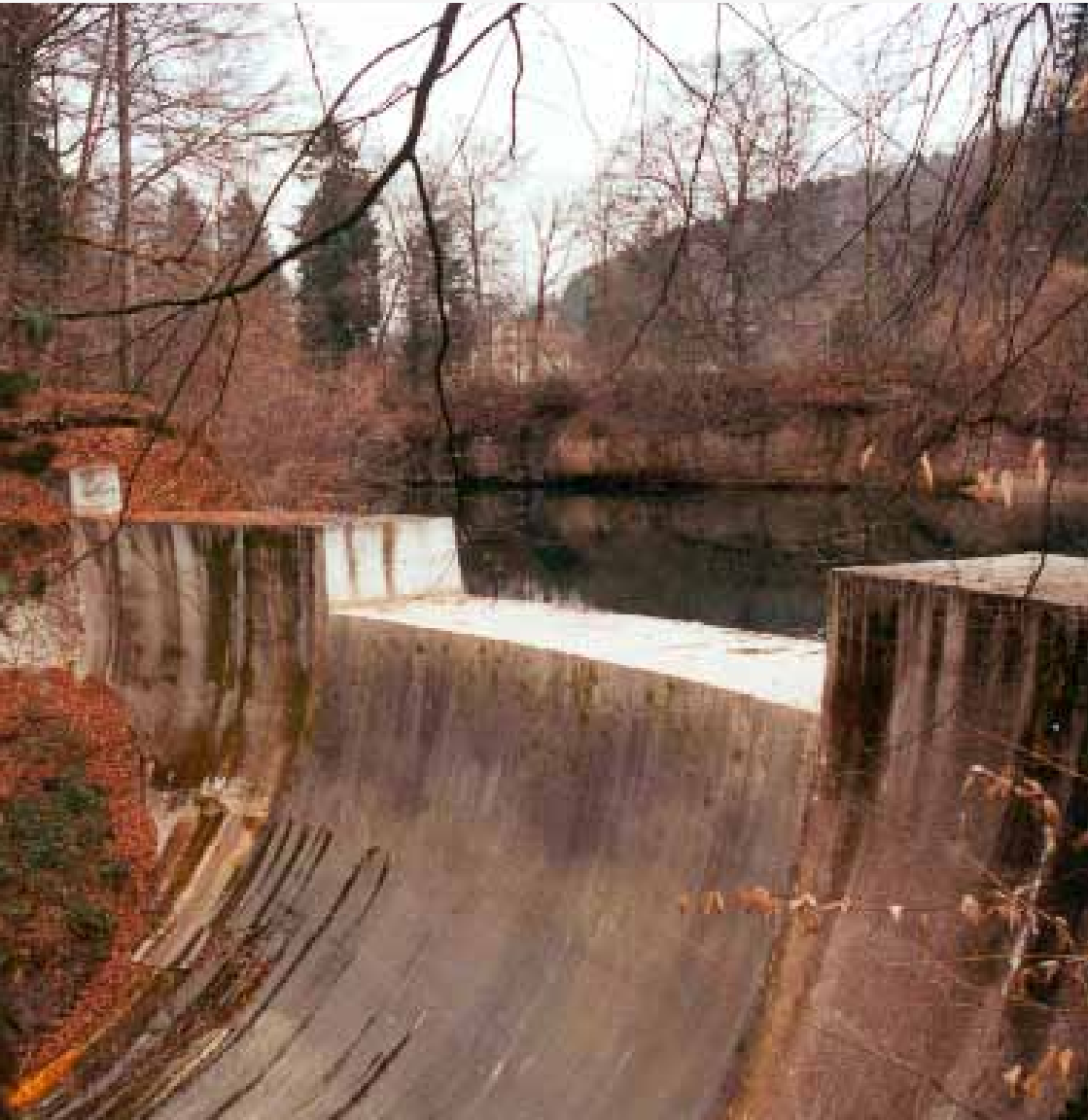
Staumauer für das Kleinwasserkraftwerk im Pilgersteg.
