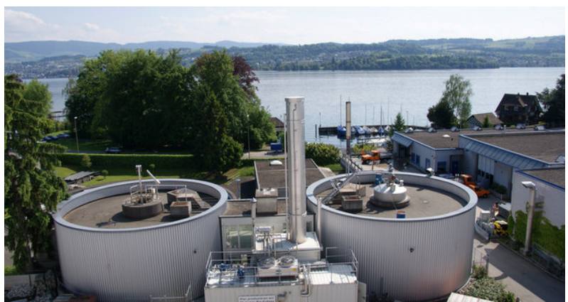
Biogas-Einspeiseanlage (Bsp. Meilen) / Bildquelle: Erdgas Zürich
